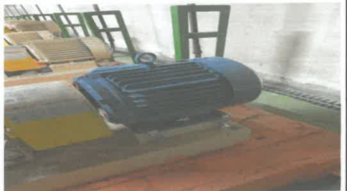
기계실 공조난방 순환펌프 1호기 교체
