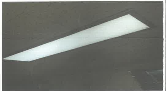
지하1층 승강기 앞 전등 교체
