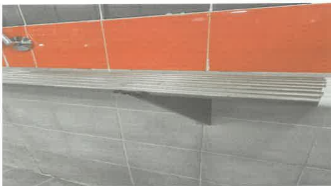
수영장 여자샤워실 비누받침대 전기용접
